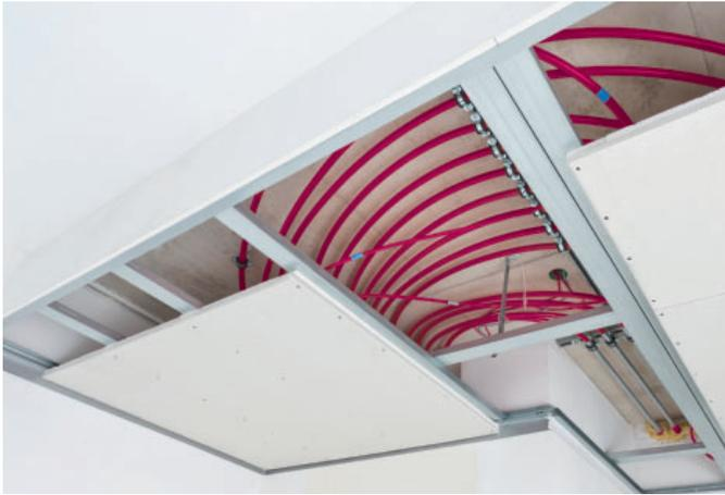
El sistema de techo REHAU se compone de elementos caracterizados por una gran superficie de intercambio de calor que sólo difiere unos pocos grados de la temperatura ambiente.
